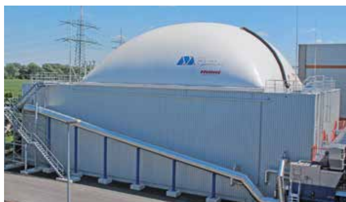
Digestore dotato di gasometro.
